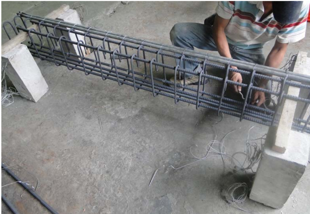
圖 C2.1 將鋼筋籠架高以利於鋼筋綁紮
