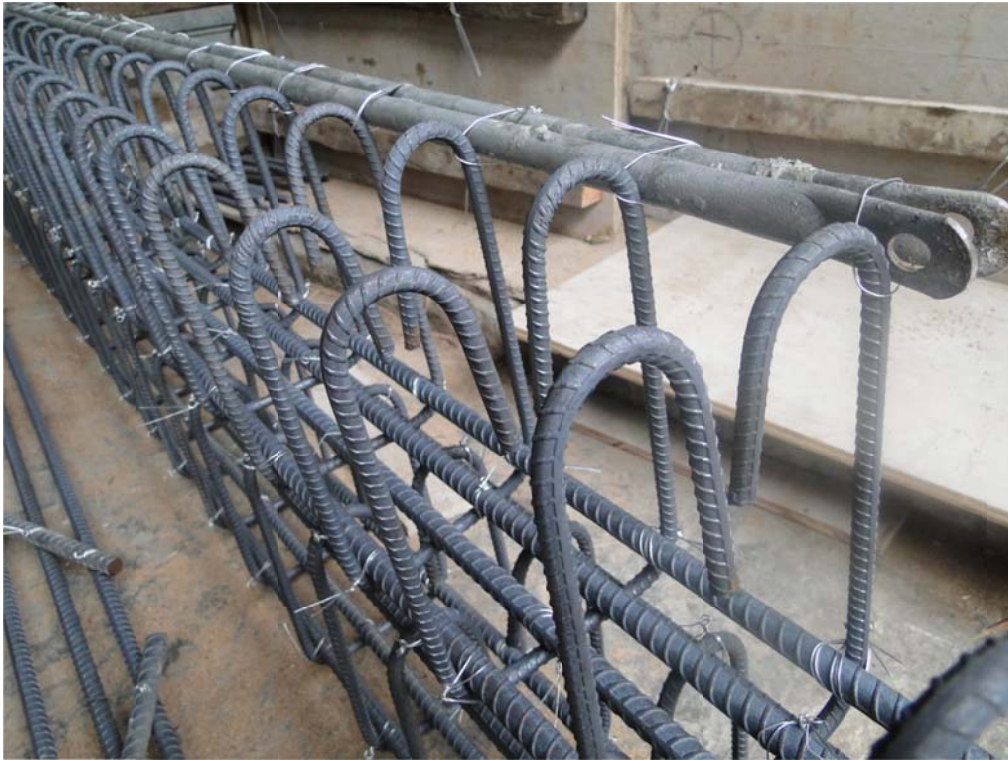
圖 C1.1 現場鋼筋籠組裝並於剪力筋上緣架設橫桿
