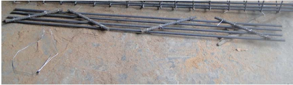
圖 C3.2 單筋梁間距之固定
