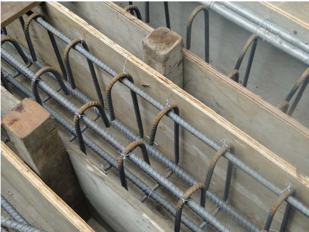
圖 C2.3 將鋼筋籠放置於模板內
