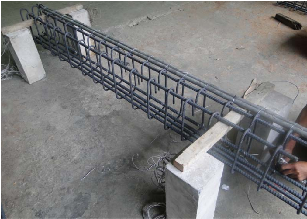
圖 C2.2 鋼筋籠架綁紮完成
