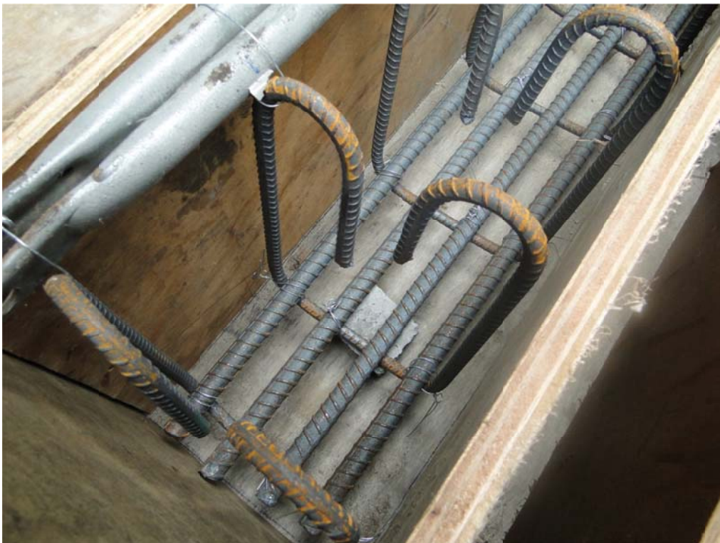
圖 C1.2 鋼筋籠放置模板內
